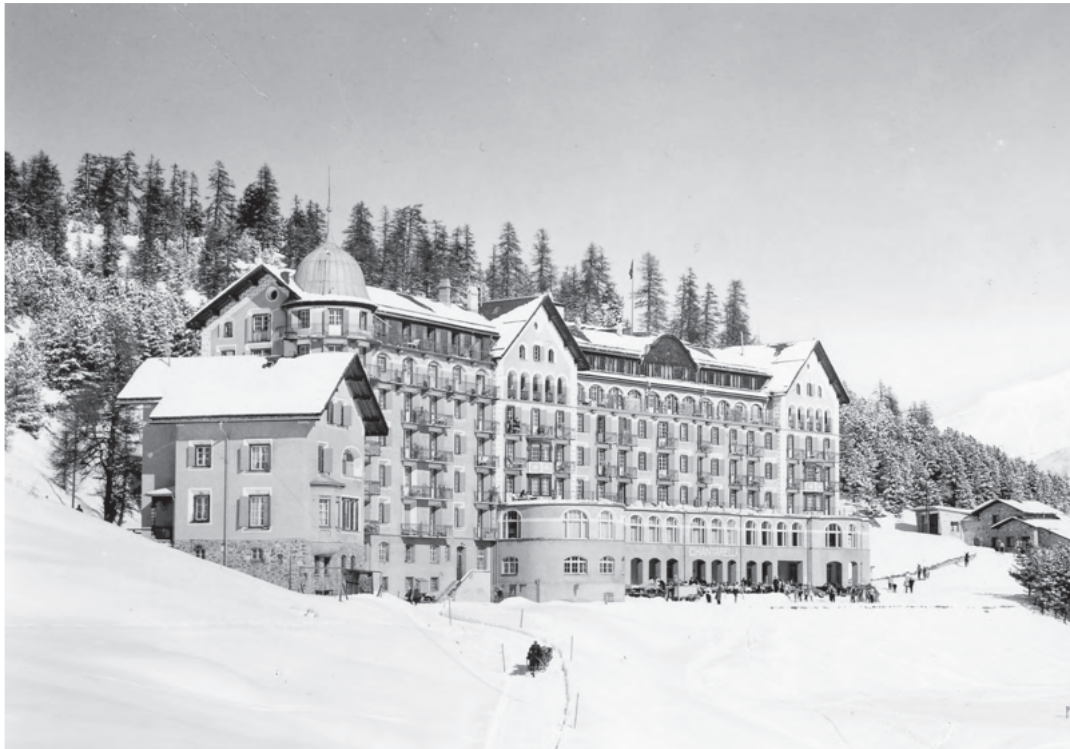
St. Moritz, Hotel Chantarella, 1912 erbaut von Architekt Emil Vogt, 2001 abgebrochen. (Eidgenössisches Archiv für Denkmalpflege, Bern)
