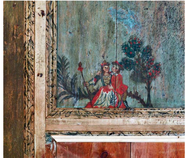
Die Malerei eines Paares ziert die Holztäferung der barocken Stube. Die fehlenden Fugenabdeckungen der Täferung sind – wo nötig – partiell ausgebessert.
